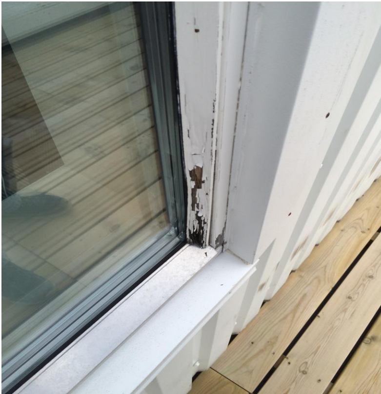
Råteskader
