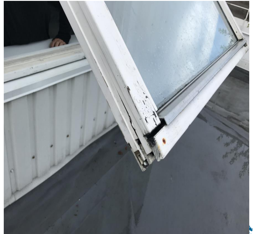
Råteskader
